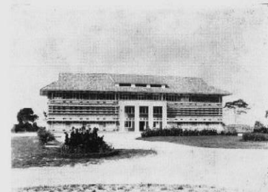
Bâtiment-bibliothèque, façade d'entrée nord.
