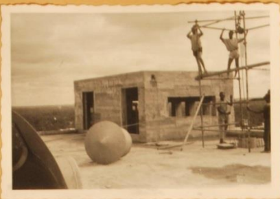
CAGE D'ASCENSEUR TOITURE SALLE DE BROSSAGE OCT. 57
