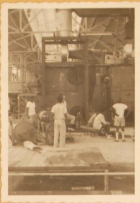
SALLE DES MACHINES
