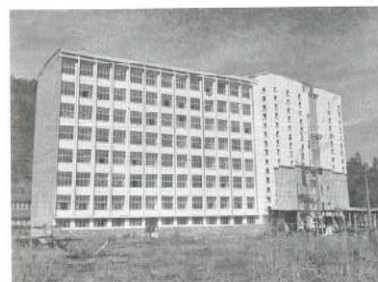
Un aspect du nouvel hôpital en construction dans la commune africaine de Kadutu, à Bukavu, chef-lieu de la province du Kivu.
