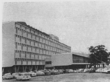
Le siège des services administratifs du Gouvernement provincial de Léopoldville. A l'avant plan, l'entrée principale et la salle d'assemblées et, masqué par les arbres, le cabinet du Gouverneur de Province, sur la toiture, le service social et la cantine.
