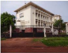
Banque Centrale du Congo, 1945-1960
